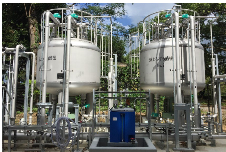
水族館・動物園等に用いられる水処理装置 浮上ろ過装置「FM フィルタ」
