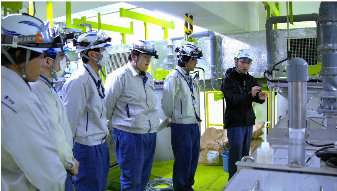
写真 1：施設の設計担当者が設備について説明する様子
