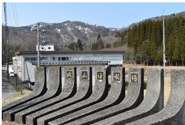
土木構造物を残しつつ機能向上し生まれ変わった城山浄水場
