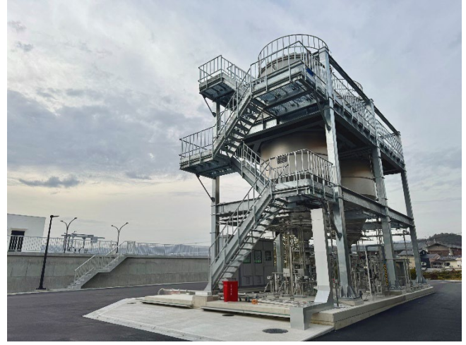
写真：ドライ粉末活性炭注入設備 カーボジェット®
